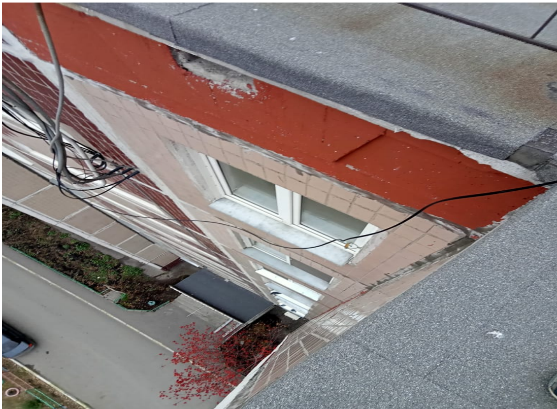
Устранение провисания аварийного кабеля на кровле
